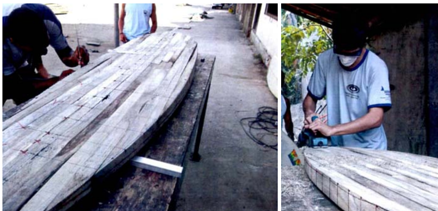
Figura 8: Etapa de curvatura da prancha
