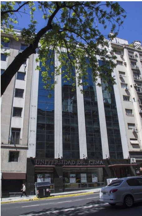
(Frontis del Edificio)
