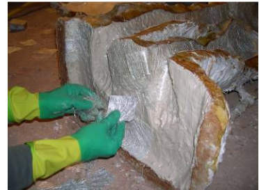
Solapado de la fibra de vidrio sobre la resina
