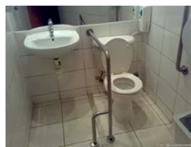
Figura 7: Baño adaptado para personas con sillas de ruedas. Fuente: http://www.ciudadaccesible.cl/wp=content/uploads/2012/05/Ba%C3%B1o-1er-piso-cl%C3%ADnica-tabancura-1.jpg
