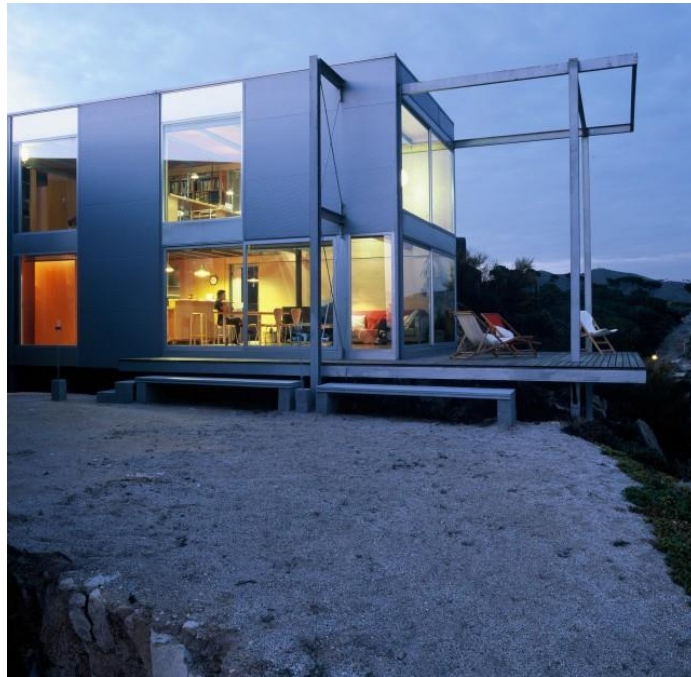
Figura 1. Casa estudio en Tiana. Fuente: Battle, M. (2008). Trabajar en casa. Vivir en la Oficina . Barcelona. Monsa Ediciones.
