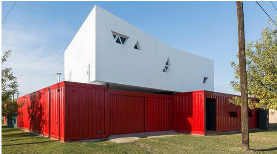
Figura 1: Vista general de la casa Container.
